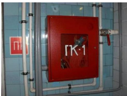
Внутренний противопожарный водопровод
