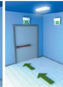
В соответствии с месторасположением эвакуационных указателей
