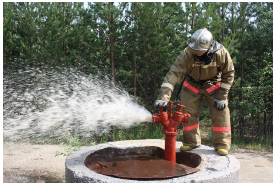
Наружный водопровод противопожарного водоснабжения
