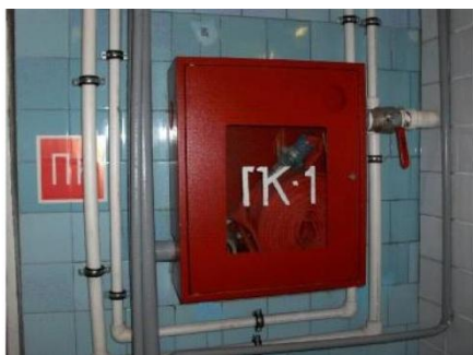
Внутренний противопожарный водопровод
