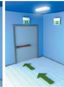
В соответствии с месторасположением эвакуационных указателей
