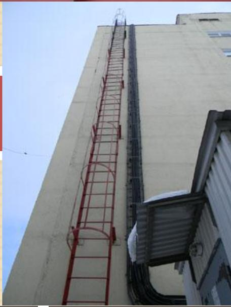
Пожарная лестница предназначена для подъёма личного состава пожарных подразделений и оборудования на верхние этажи зданий для тушения пожара и для спасения людей.
